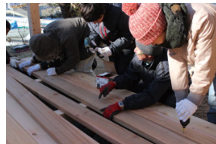
ウッドデッキ 施工
